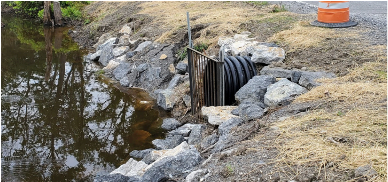
POWERS, S. 2024. CULVERT NEW LEBANON, NY
