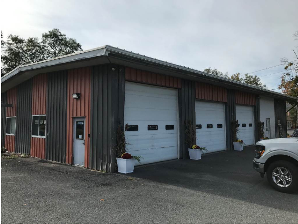
Garage Door Caulk
